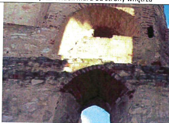
Fot. 9/A2. Widok muru z przemurowaniami kwarcytem
