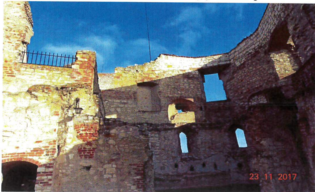
Fot. 40Sekcja A, widoczne pozostałości tynków w gładach okiennych i w ich przemurowaniach.
