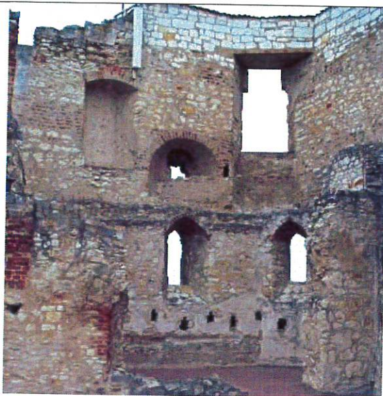
Fot. 5/A2. Widok muru od strony wnętrza
