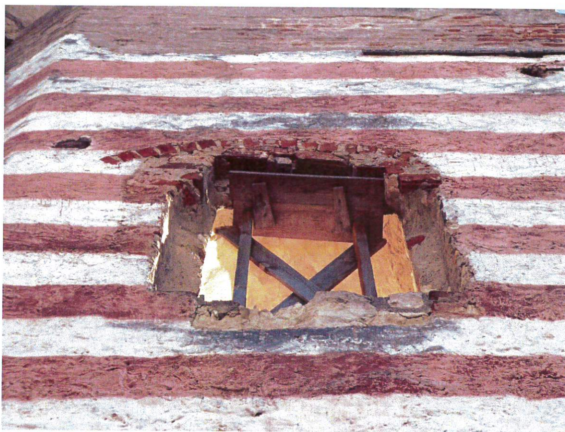
Fot. 42 Sekcja C, zachowany otwór okienny z XVI w., widok od strony dziedzińca, widoczne gniazda po blokach kamiennych obramienia. Dony fragment zachowany w złym stanie.
