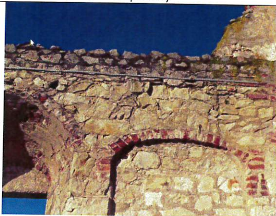
Fot. 21/B. Uszkodzenia muru z opoki wapnistej pod pasem z kwarcytu.
