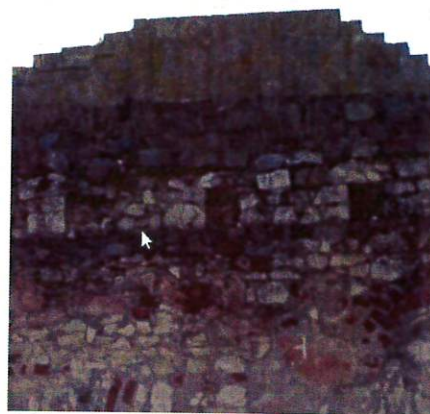
Fot. 34/F. Zdegradowany materiał murowy wokół otworów po belkach
