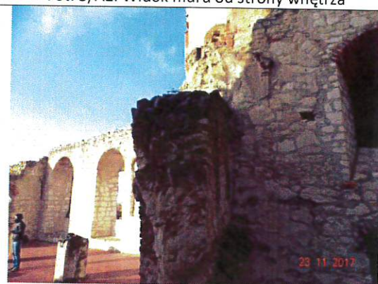
Fot. 7/A2. Widok muru od strony wnętrza
