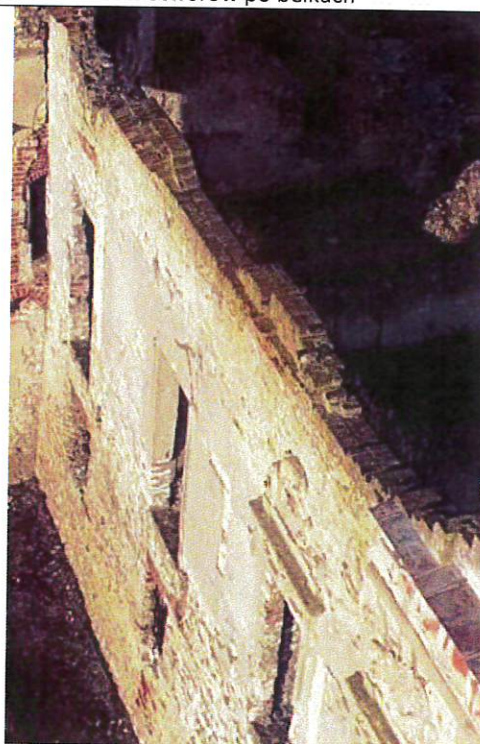
Fot. 36/F. Widok korony muru z góry
