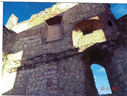
Fot. 8/A2. Widok muru od strony wnętrza
